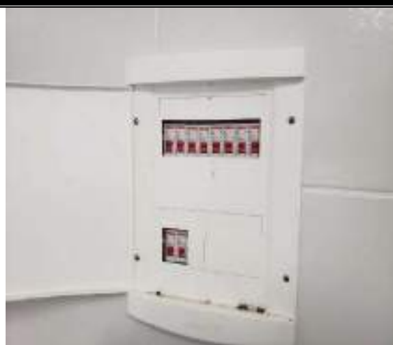
FOTO 13: Quadro de disjuntores.
